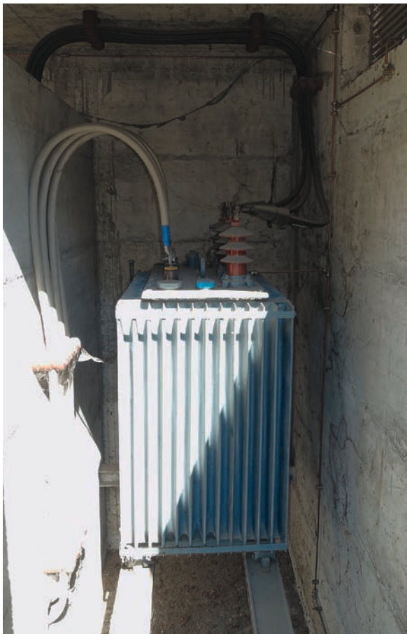
Der fast 40 Jahre alte Transformator (links) wurde durch einen neuen mit höherer Leistung ausgetauscht.
