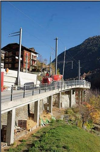
Das Tiefbauwerk „Wendeplatte Bielmattenstrasse“ wird saniert. Die SRP Ingenieur AG hat die Tragkonstruktion bei der Wendeplatte östlich der Überfahrt Bahnhof Stalden überprüft und ein Instandsetzungskonzept erarbeitet. Die Kosten werden teilweise von der MGBahn übernommen.
