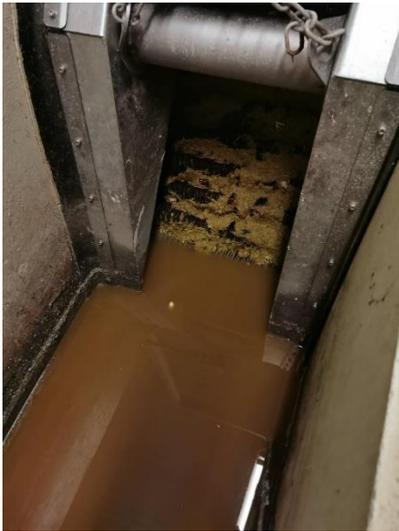
Gülle ist bereits mehrmals in die Kanalisation eingeleitet worden. Dies wird in der Regel durch die dunkelbraune Farbe und anhand der Strohfasern im Rechen festgestellt.
