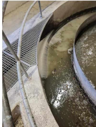
Milchbestandteile im Abwasser werden in der Regel durch eine weisse, trübe Färbung bei Milch oder auch über die leicht grün schimmernde Farbe bei Molke erkannt.
