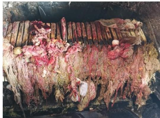
Einlaufrechen der ARA vollständig verstopft durch Schlachtnebenprodukten. Die manuelle Reinigung des Rechens ist sehr aufwendig.
