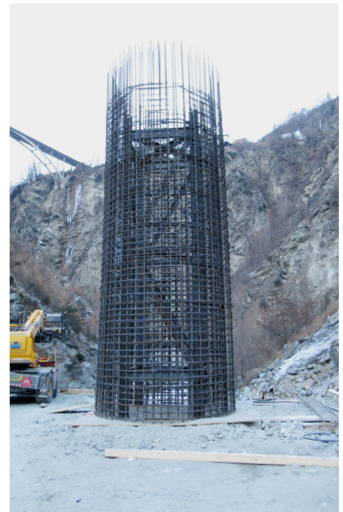
Links: Pfeiler 1 im Bau: das schwindelerregende Treppengerüst Rechts: Die konisch-förmige Bewehrung zum Betonieren des ersten Pfeilerabschnittes, Dezember 2017
