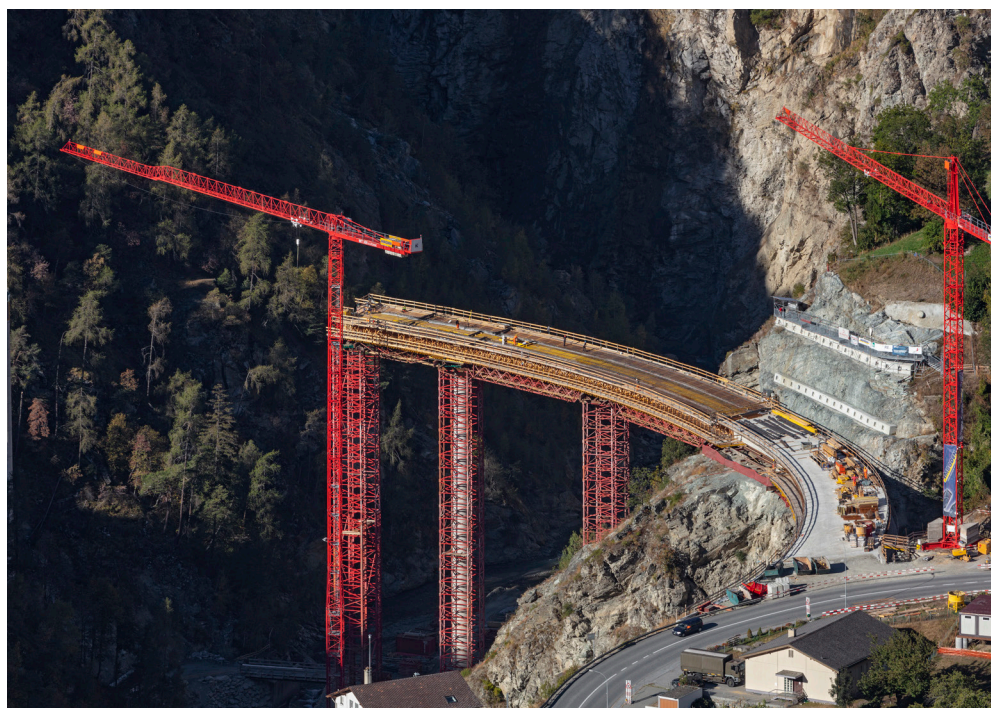
Die abgetragene und gesicherte Felsnase, die Hilfsbrücke unten im schwer zugänglichen «Chi», Brückenbau zweite Etappe
