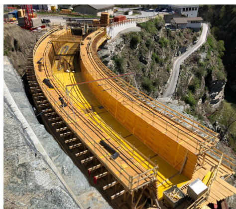
Bauetappe 1: Schalung für den Brückentrog und den Brückenüberbau
