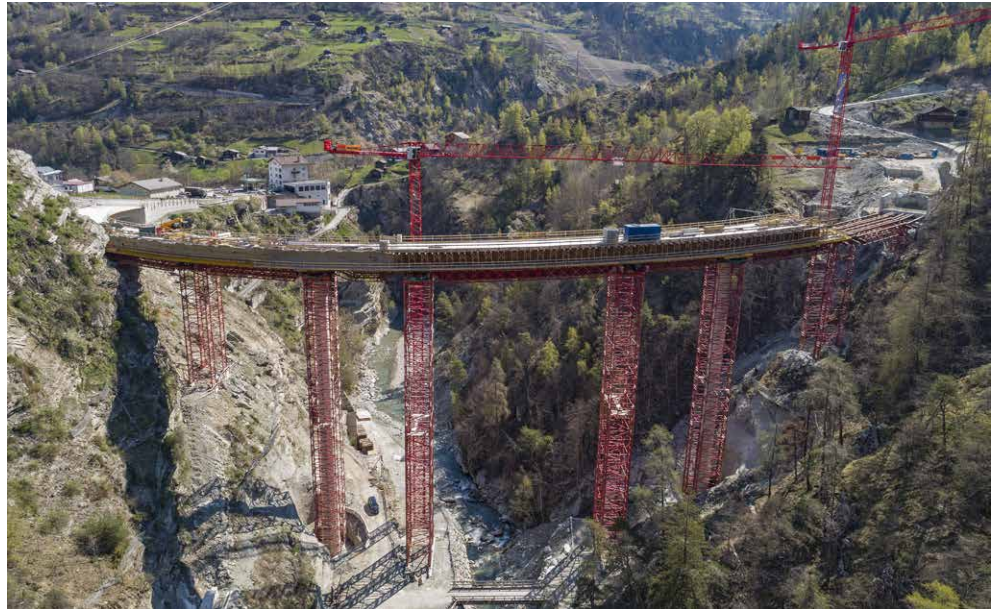
Das rote Leegerüst mit seinen 6 Pfeilern: 1'100 t Stahl
