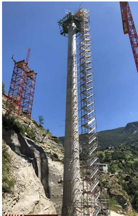
Links: Pfeiler 1 im Bau: das schwindelerregende Treppengerüst Rechts: Die konisch-förmige Bewehrung zum Betonieren des ersten Pfeilerabschnittes, Dezember 2017
