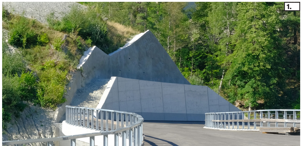
Hanganschnitt Klein Matterhorn: 40 m lang, 12 m hoch
