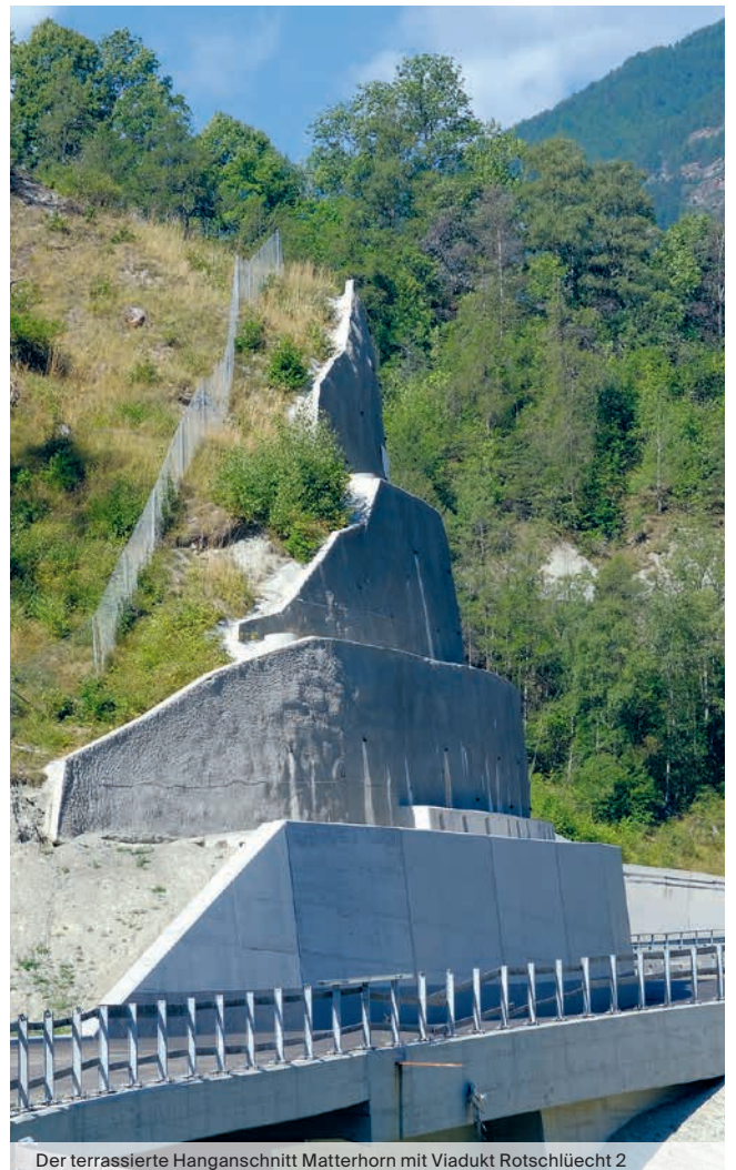
Der terrasierte Hanganschnitt Matterhorn mit Viadukt Rotschlüecht 2
